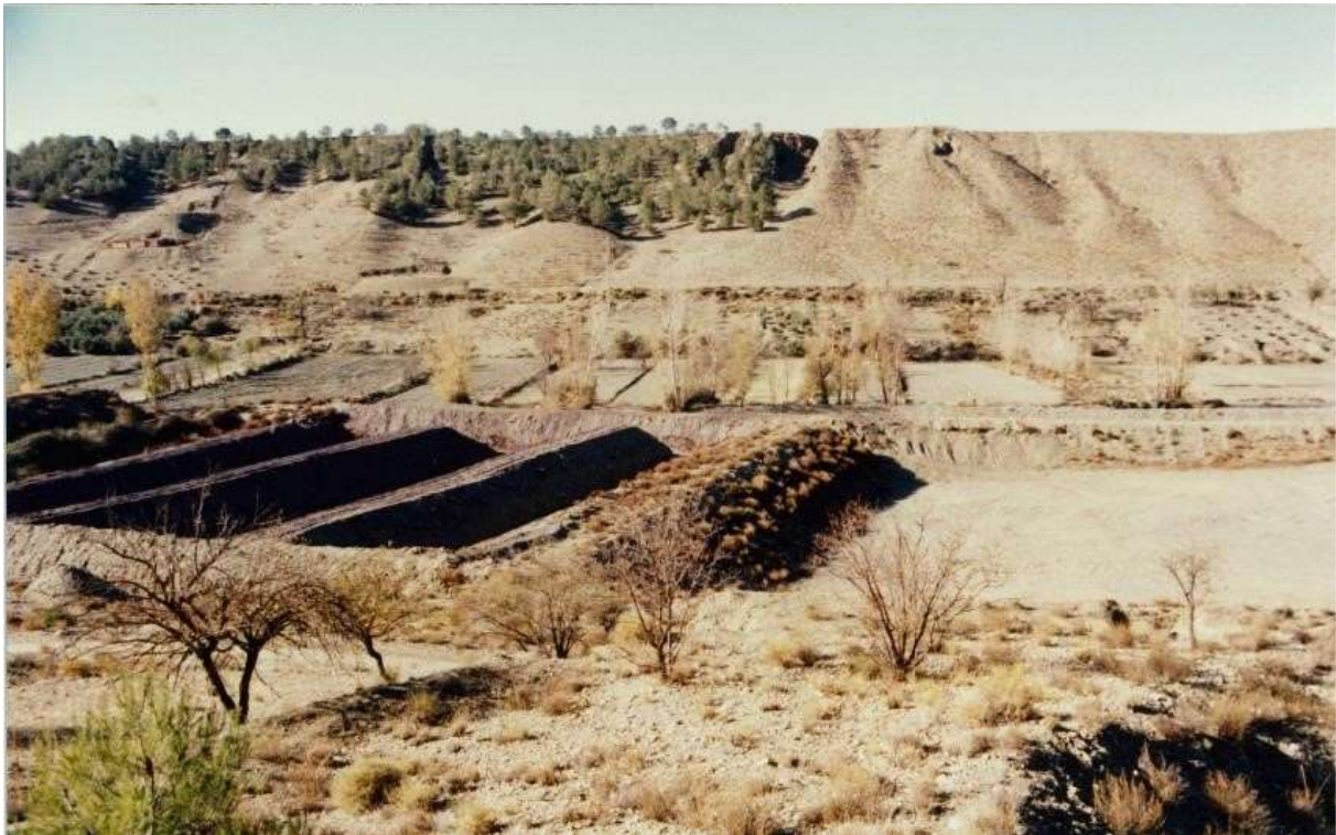
Figura 95: Balsas de recarga artificial en la cabecera del río Verde de Guadix 1984-1990.
