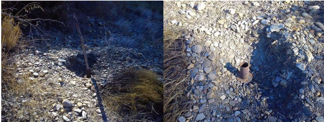
Foto 46: Estado del sondeo 2141/5/0036 antes del acondicionamiento.
