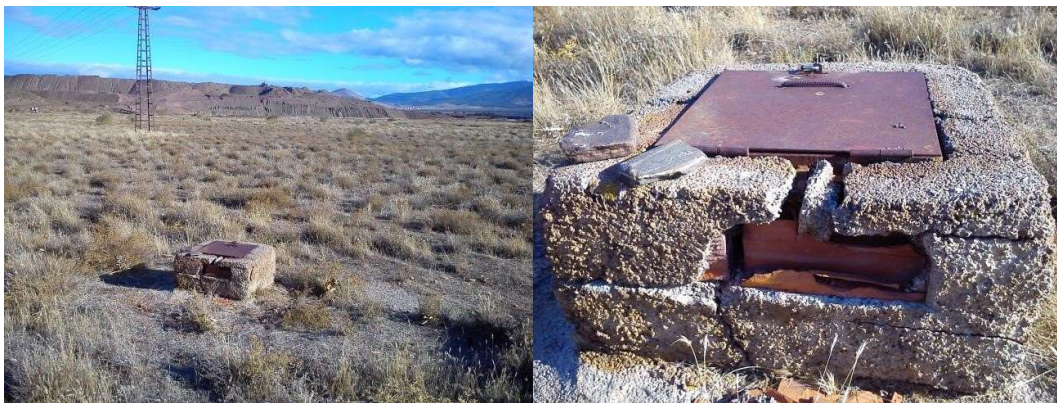
Foto 48: Estado del sondeo 2141/5/0265 antes del acondicionamiento.
