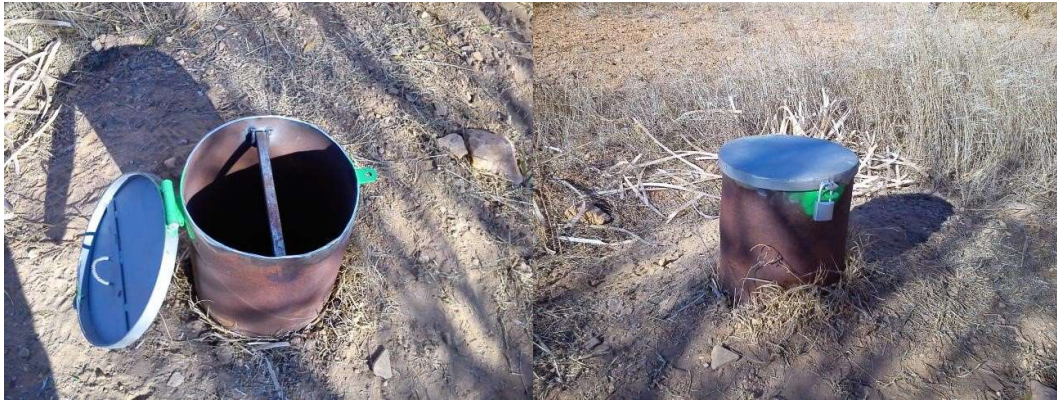
Foto 43: Estado del sondeo 2141/7/0028 tras el acondicionamiento.
