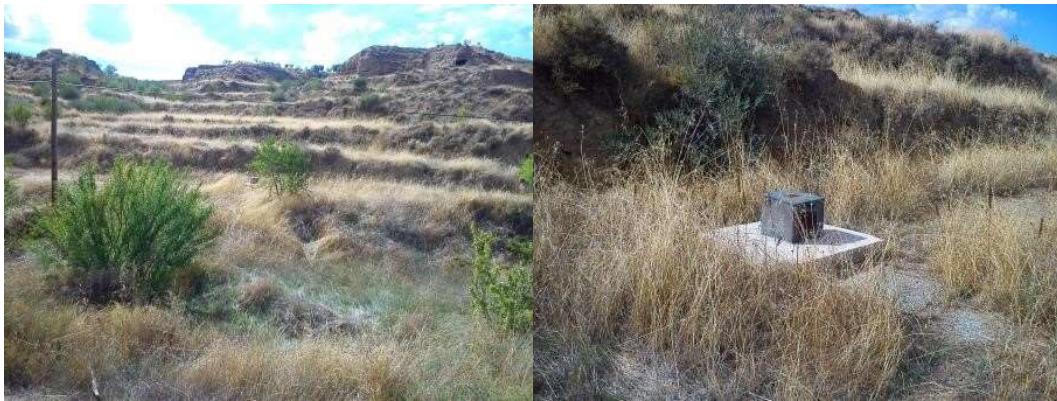
Foto 2: P2 - Alcantarilla Baja-Rambla del Patrón - (2141/1/0225)
