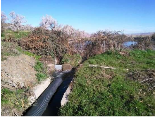
Figuras 80 y 81: Entrada de agua procedente de la depuradora de Aldeire a la balsa (B).
