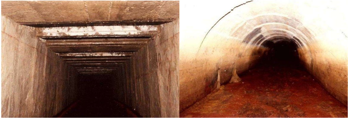
Figura 66. Estado actual de la mina y galería en el aluvión.
