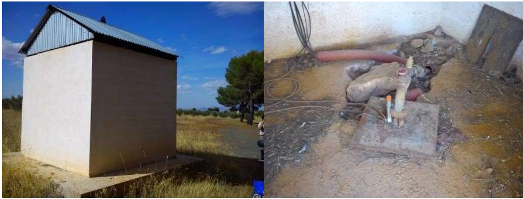
Foto 1: P1 - Cantera Cerro Sillado - (2041/8/0006)
