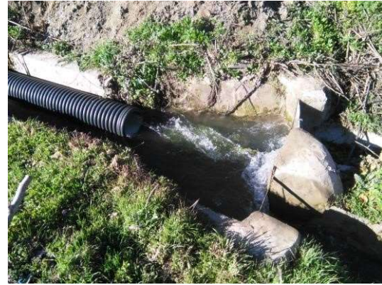
Figuras 80 y 81: Entrada de agua procedente de la depuradora de Aldeire a la balsa (B).
