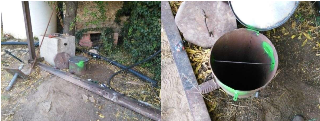
Foto 50: Estado del sondeo 2141/7/0015 tras el acondicionamiento.
