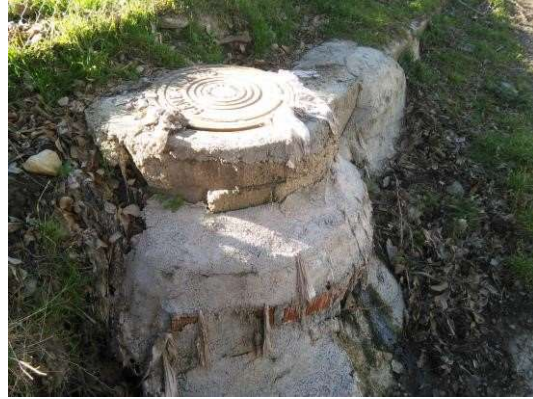
Figuras 84 y 85: Punto de registro de aguas residuales, junto al cauce, con evidencias de contaminación y vertidos de aguas residuales (fotografía 08/03/2017).
