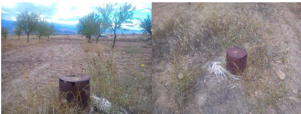
Foto 42: Estado del sondeo 2141/7/0028 antes del acondicionamiento.
