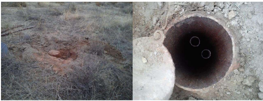
Foto 44: Estado del sondeo 2141/5/0027 antes del acondicionamiento.
