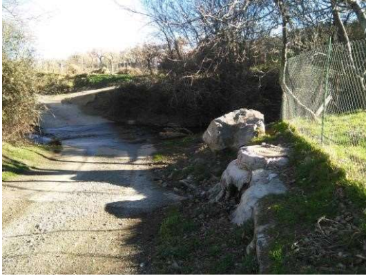
Figuras 84 y 85: Punto de registro de aguas residuales, junto al cauce, con evidencias de contaminación y vertidos de aguas residuales (fotografía 08/03/2017).
