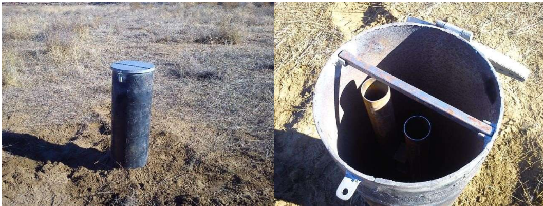
Foto 45: Estado del sondeo 2141/5/0027 tras el acondicionamiento.
