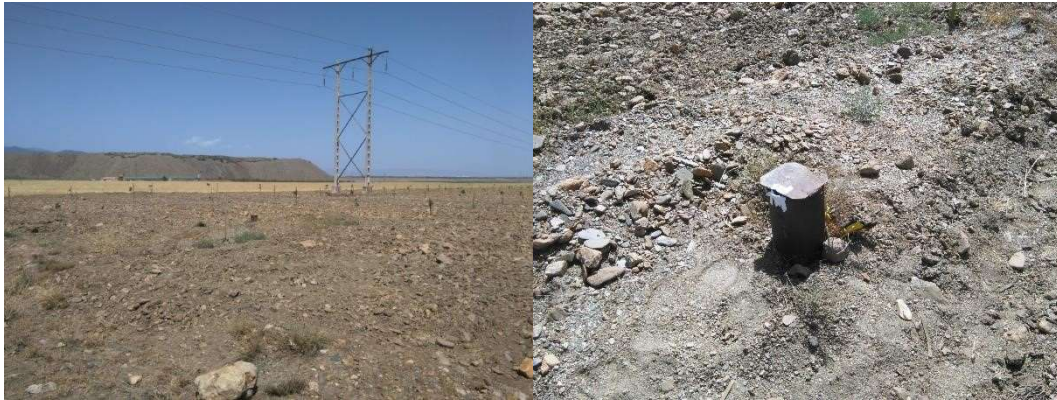
Foto 36: P36- Nº 49 Mina (2141/5/0100).
