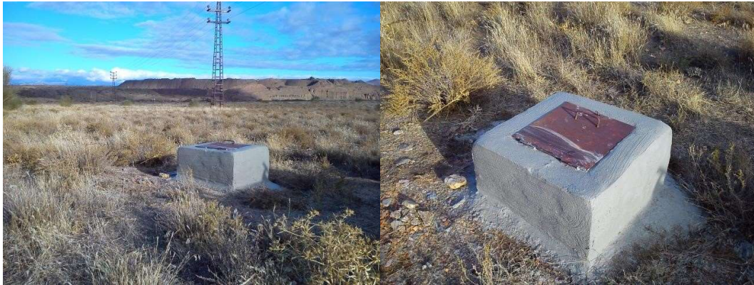
Foto 49: Estado del sondeo 2141/5/0265 tras el acondicionamiento.
