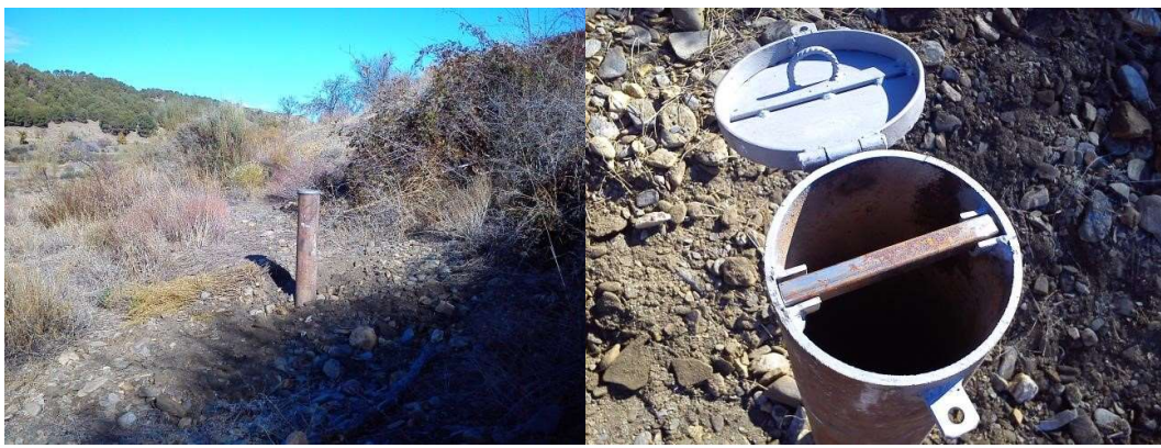
Foto 47: Estado del sondeo 2141/5/0036 tras el acondicionamiento.
